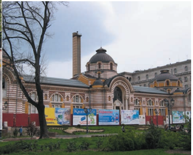
写真2 左写真の隣にある改修中のトルコ式銭湯。
