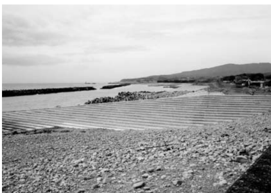
写真8 奈半利貯木場の浜。立派な傾斜護岸と大規模な離岸堤が延々と続いている。
