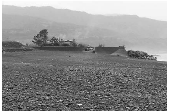
写真5 砂礫の浜と土場。海側に高い防潮堤とその足元に並べられたテトラポッドが見える。
