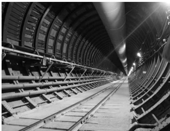
写真10 ESF北斜坑の内部。
