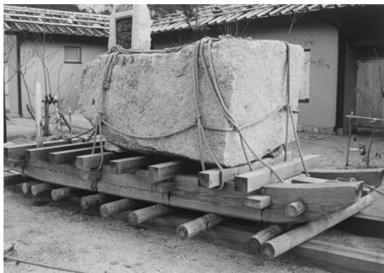
写真3 大坂城残石記念公園に復元された「修羅」(所在地:香川県小豆郡土庄町小海). 往時,「修羅」は巨石の陸上搬送のために使用したとされる.様々な形や大きさがあり,写真に見られる「修羅」は檜材を用いてはしご状に造作されている.
