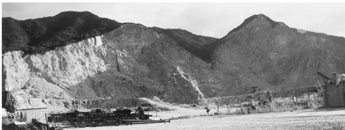
写真7 「灘山型」花崗岩の採石丁場(位置:土庄町小部(通称;灘山)). 本地区の採石丁場は小豆島北部海岸に沿って北東~南西方向に約2km展開し,切羽高は30-100mに達する。
