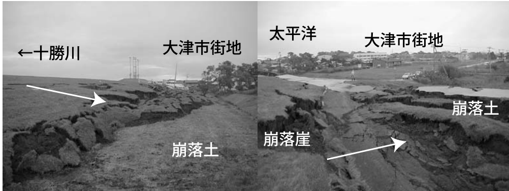
第4図 十勝川河畔の大津市街地築堤において生じた大規模側方流動、付近には各種の液状化痕跡が認められた。白い矢印は流動方向の向きを示す。
