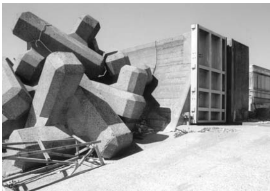
写真7 十市海岸。高い防波堤と大きなテトラポッドで守られている。
