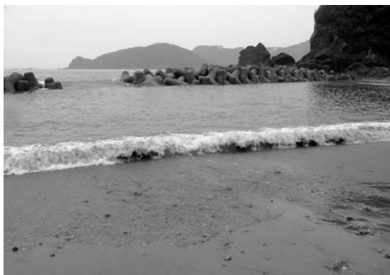
写真24 新居海岸の西端部。離岸堤に守られた砂浜がわずかに残っている。
