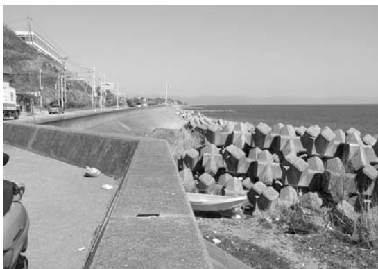
写真17 東戸原海岸。防波堤の外側にはテトラポッドが並べられ、砂浜は殆ど残っていない。
