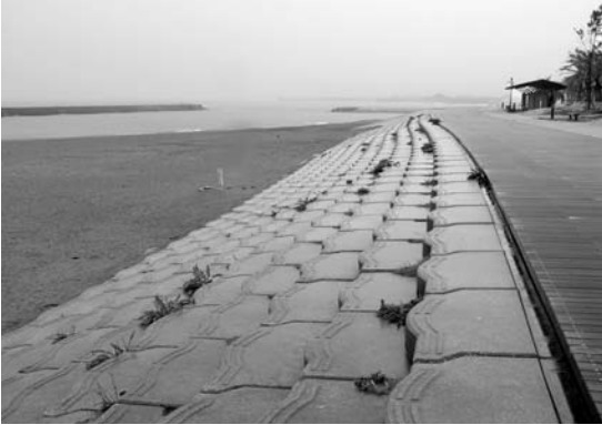
写真1 手結海岸. 手結港と道の駅の間に整備された人工海岸.
