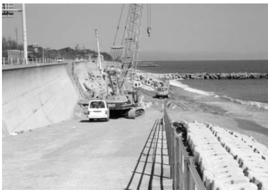
写真15 浦戸海岸。防波堤の補強工事がたゆまなく進められている。
