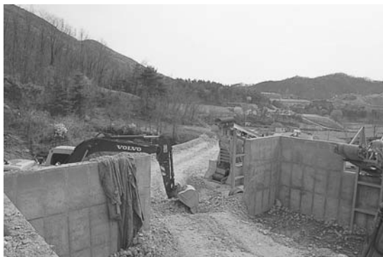
写真1 貯鉱場越しに見た再開発中のムクック鉱山風景。
