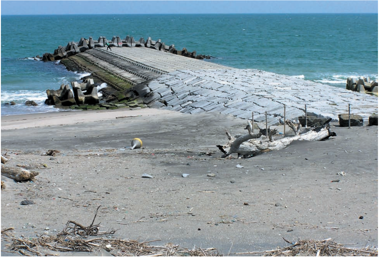
写真3 ヘッドランドの一例(宮城県山元町の海岸)：海岸の砂の移動を防ぐために海岸に設置されている構造物。先端部に釣り人の姿が見える。
