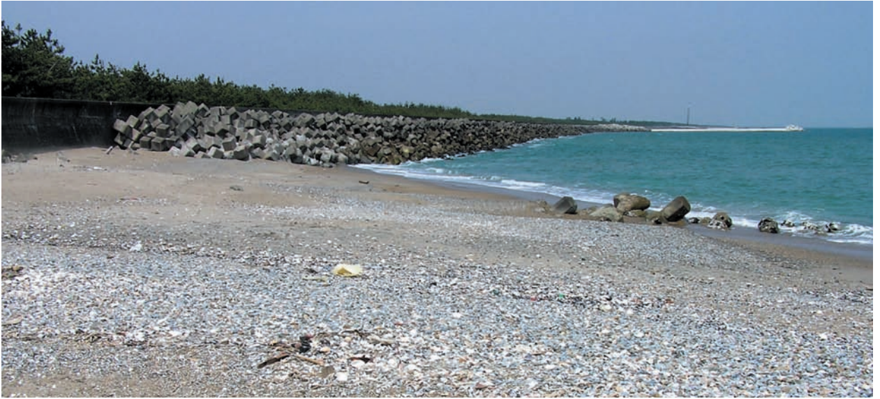
写真1 宮城県山元町磯浜漁港北側の海岸：松原の海側に造られた防波堤の足元にテトラポッドが並べられている、かつては松原を抜けると白砂の浜が広がっていただろう。画面右上の白い線は、ヘッドランド(写真3)。
