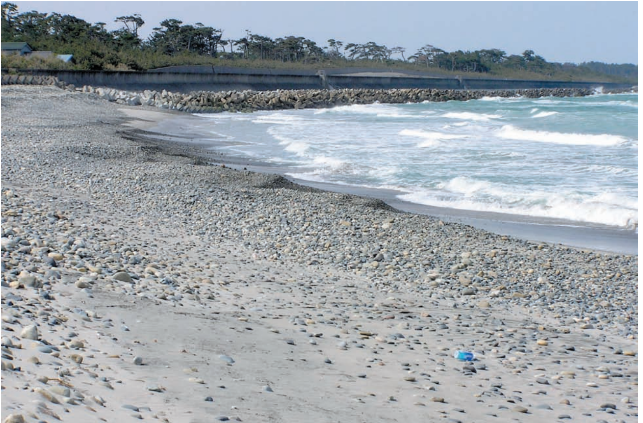
写真2 福島県鹿島町右田浜：真野川河口の北側に広がるこの浜もかつては白砂青松の浜であったが、磯浜漁港北側の海岸によく似た状況となっている。
