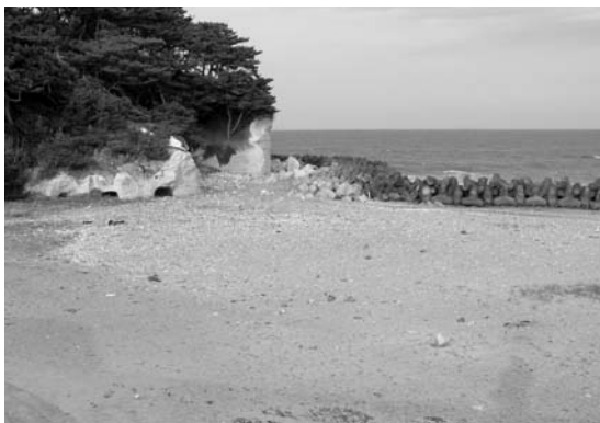
写真23 砂州の北端部. 明治後期にはここで松川浦と太平洋が繋がっていた.
