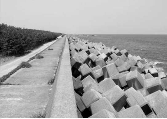
写真13 防潮堤とテトラポッドの浜。延々と続く防潮堤とテトラポッドの浜が遠くまで続いている。
