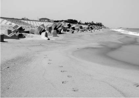
写真6 碇浜。傾斜護岸の下に並べられたテトラポッドも砂に埋もれかけている。
