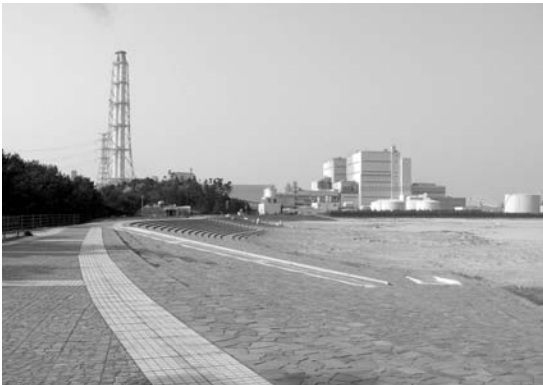
写真32 北泉海浜公園の人工海浜。発電所の南側に設けられた緩傾斜護岸と人工海浜。
