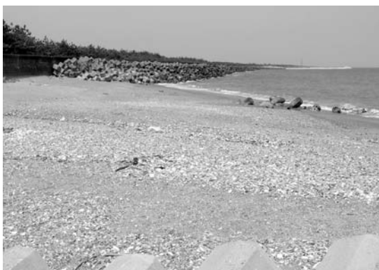
写真12 防潮堤とテトラ・ポッドの浜。砂浜は失われているが、陸側には松原が延々と続いている。
