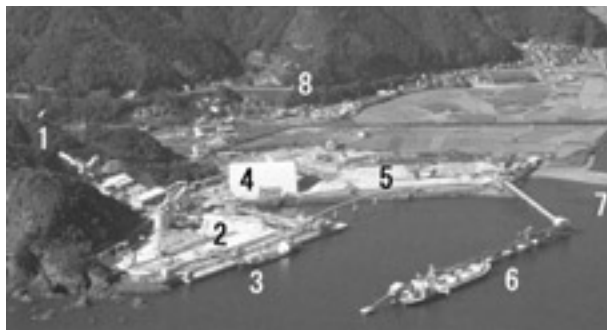
写真15 須崎事業所の全景。1. ベルトコンベア、2. 砕砂の貯鉱、3. 埠頭(1万トン級)、4. 鉄鋼原料倉庫、5. セメント原料用貯鉱、6. 埠頭(6万トン級)、7. 新莊川河口、8. 国道56号線。
