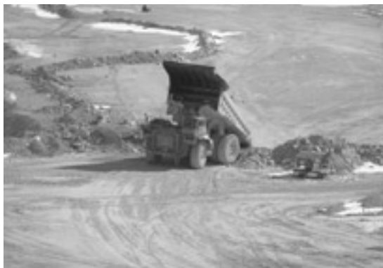
写真7 堅坑への鉍石の投入.
