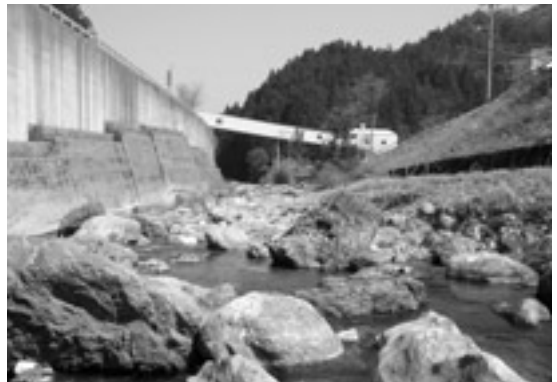
写真12 ベルトコンベアの渡り廊下.
