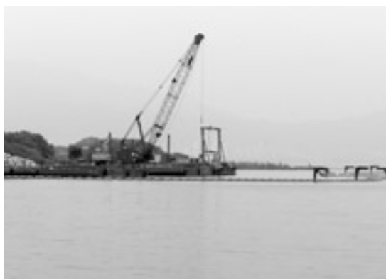
写真1 工事が行われる琵琶湖の湖畔. 草津市の琵琶湖・淀川水質浄化センター付近で撮影.
