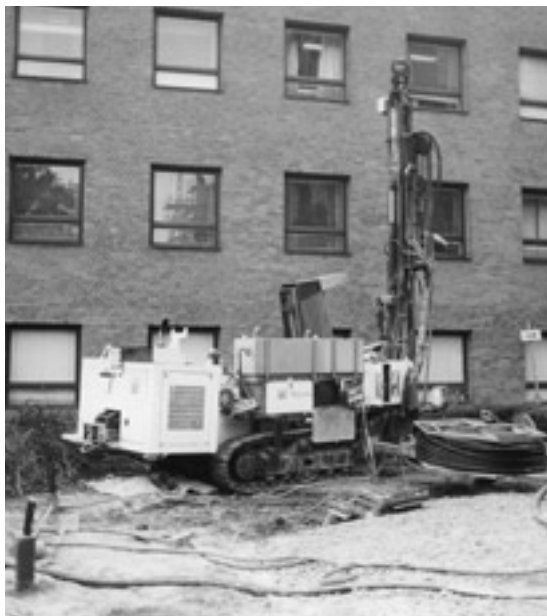
写真1 スウェーデンのルンド大学での導入例。 中型トラック1台に収まるコンパクトな掘削機。 右手の巻物はU字管用チューブ。
