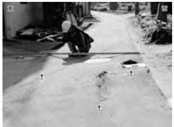
写真4 六日町盆地西縁断層沿いでみられるアスファルト舗装道路の圧縮変形(Loc. 6)。
