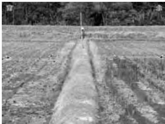
写真3 小平尾集落南方の水田を変位させる地震断層 (Loc. 4)。ここでは西上がり約15cmとともにわずかな左ずれが認められる。
