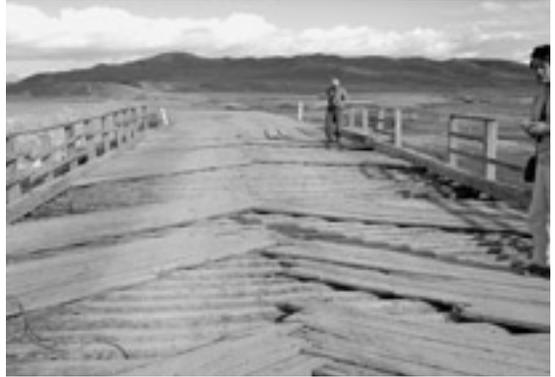
写真7 表面の板木が剥がされた木造の橋。
