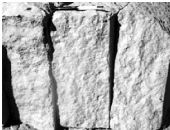
写真2 札幌軟石として塀や石壁に用いられる溶結部.
