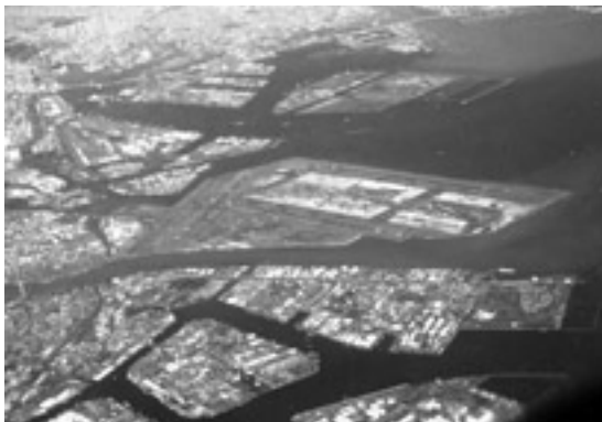
写真1 再拡張される羽田空港。現在の空港の南東側沖合に4本目の滑走路が建設される予定です。
