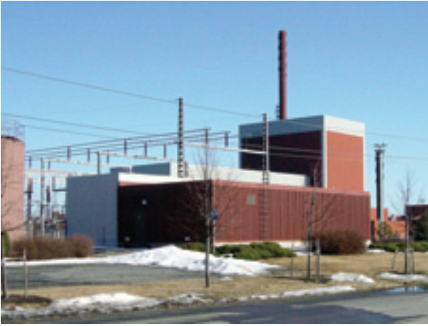
5. オルキルト原子力発電所。この原子力発電所(軽水炉)は1979年にスウェーデンの技術的支援により建設された。1982年に増設された二号機とあわせて840MW×2の出力を持つ。
