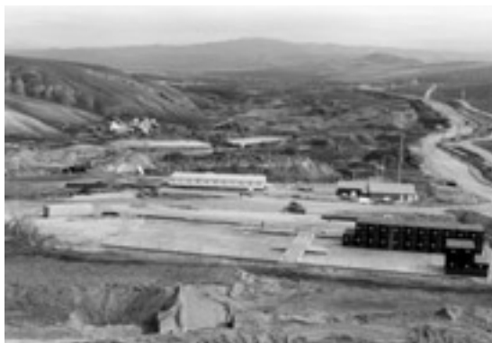
写真2 ボロー鉱山。選鉱、製錬施設が建設中(2003年9月)。
