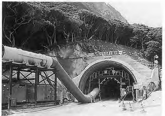
第7図 崖堆積物下に開けられた平成新島トンネルの南坑口(2002年6月15日撮影)。遠景は赤崎沢南方の山腹崩壊源。送風のための太い円管は、切羽直前まで伸びる。
