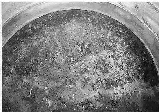
第9図 若郷側切羽写真1. 坑口から1,140mの宮塚山溶岩黒曜石質部分(W8-2)。第9図と第11, 12図は新島出張所工事担当係提供の写真。切羽の最大幅は約14m。
