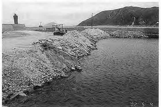
第16図 埋立開始3ヵ月後の状況。灯台の位置は、第1図の岸壁に対応。水平線上の三角形の島は、最近活火山と認定された利島。
