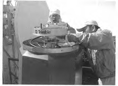
第18図 富士山電子基準点設置工事(アンテナ部の取り付け)。
