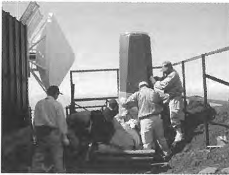
第16図 富士山電子基準点設置工事。
