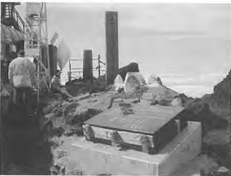
第17図 富士山電子基準点設置工事(電子基準点と三角点、手前は説明板)。
