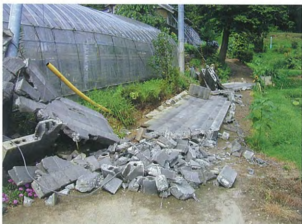
3. 矢本町小松(鷹の池付近)におけるブロック塀の倒壊.
