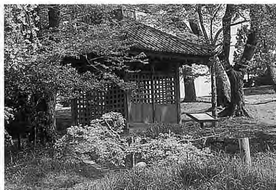
写真7 多賀城の「壺碑」を覆う「鞘堂」(宮城県).
