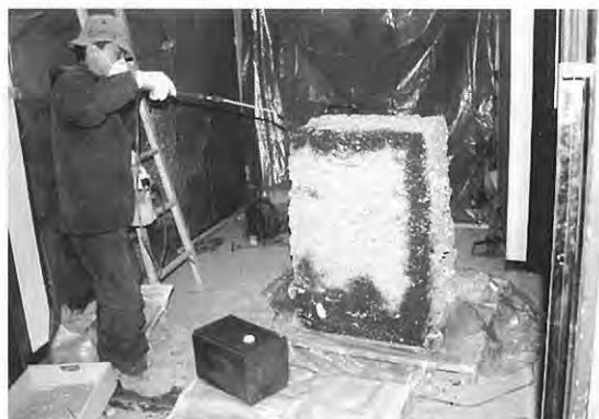
写真7 被膜材を電動スプレーを用いてまんべんなく塗る。
