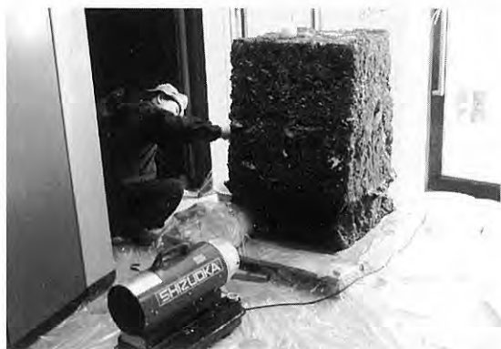
写真9 温風器を使って乾かしながら含侵剤を塗り込む作業を繰り返す。
