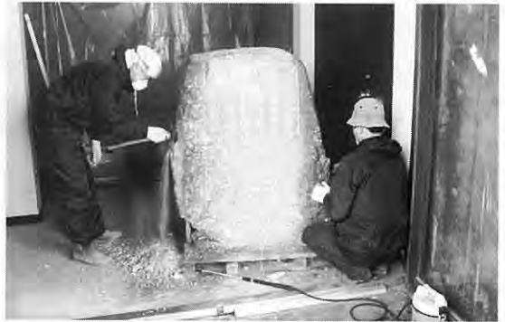
写真2 切り出したブロックの成型を始める。
