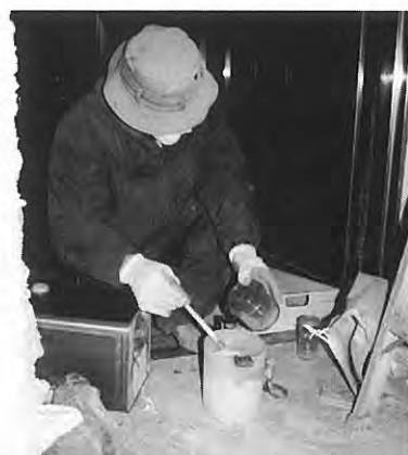
写真6 ブロック表面を固定するための被膜材を調合する。
