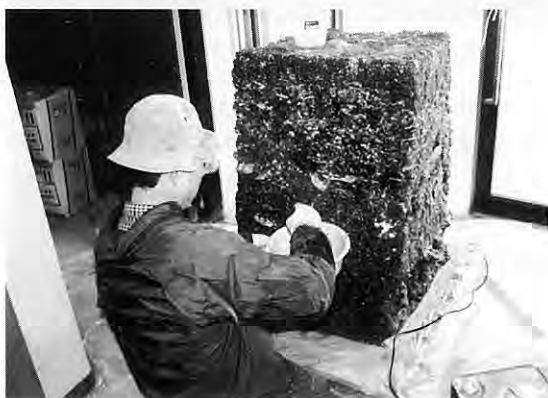
写真12 最後に被膜材を塗布して完成。
