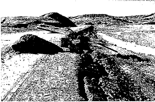
写真1 (第1図のサイト1) 青藏道路(Qingzang Highway) (2,894km地点の標石付近)を横切る地震断層(南方を望む, 徐 錫偉氏撮影)。
