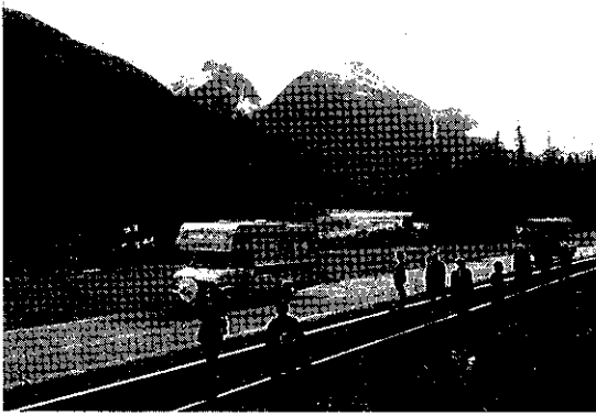
写真14 プリンズ ルパート-テラス横断面(1):横断街道と横断鉄道。
