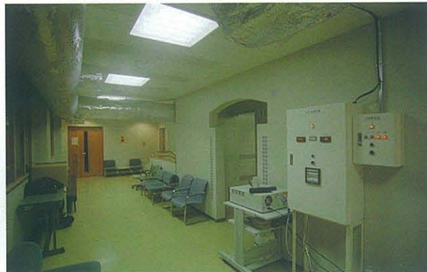
6. クリーンルーム内には、屋外に設置された空気清浄化装置から銀色のパイプを通してきれいな空気が送られてきており、計測装置によって二酸化硫黄濃度が監視されている。
