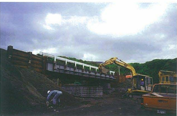
11. 泥流で流された都道を復旧するために建設される芦穴仮設橋。橋の側面のパイプは水道管。都道と共に被害を受けた水道は、2001年6月に島の南側の水源から島の北側の支庁まで西まわりで開通した。
