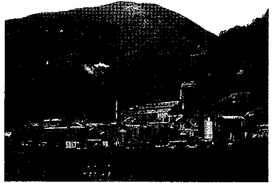
第4図 神岡鉱山鹿間選鉱場の全景。
