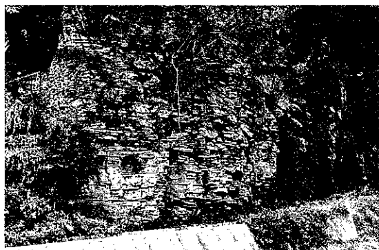
写真4 八丁地川沿いの道路脇に露出する鉄平石。鉄平石の産出レベルに道路が造られており、至るところにこのような露出を見ることができる。
