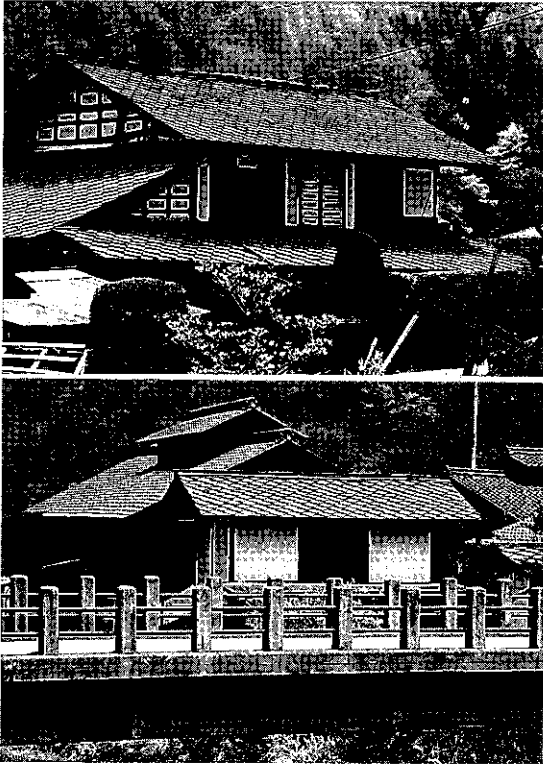
写真7 八丁地川沿いの民家の屋根。大きな石葺き屋根も残っている(上)が、母屋は陶器瓦に葺き替えられてしまっていること(下)も多い。
