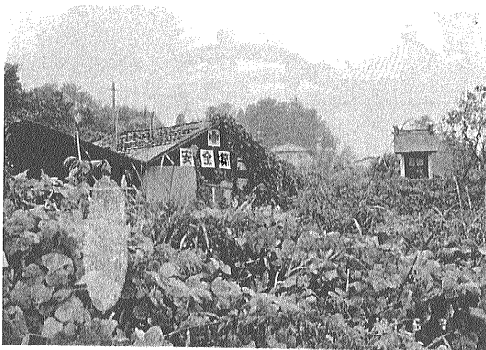
写真10 放置されて荒れ果てた旧・越前石(株)の採石跡地。写真中央の小舎掛けが旧立坑坑口。入坑はできない。写真右側に見られる御堂は、採石作業の安全を祈願したのである。
