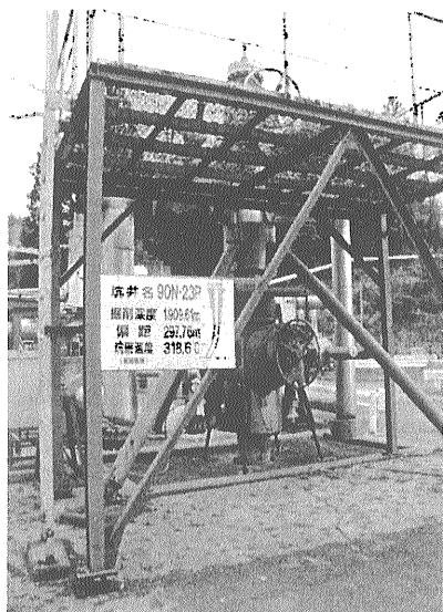
第12図 大深度の坑井などから構成される生産基地。
