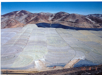
4. セロ ウェルデ鉱山のリーチンググラウンド、黒色のポリシンを敷き、その上に低品位の鉱石を乗せ、水をかけてリーチングする。
