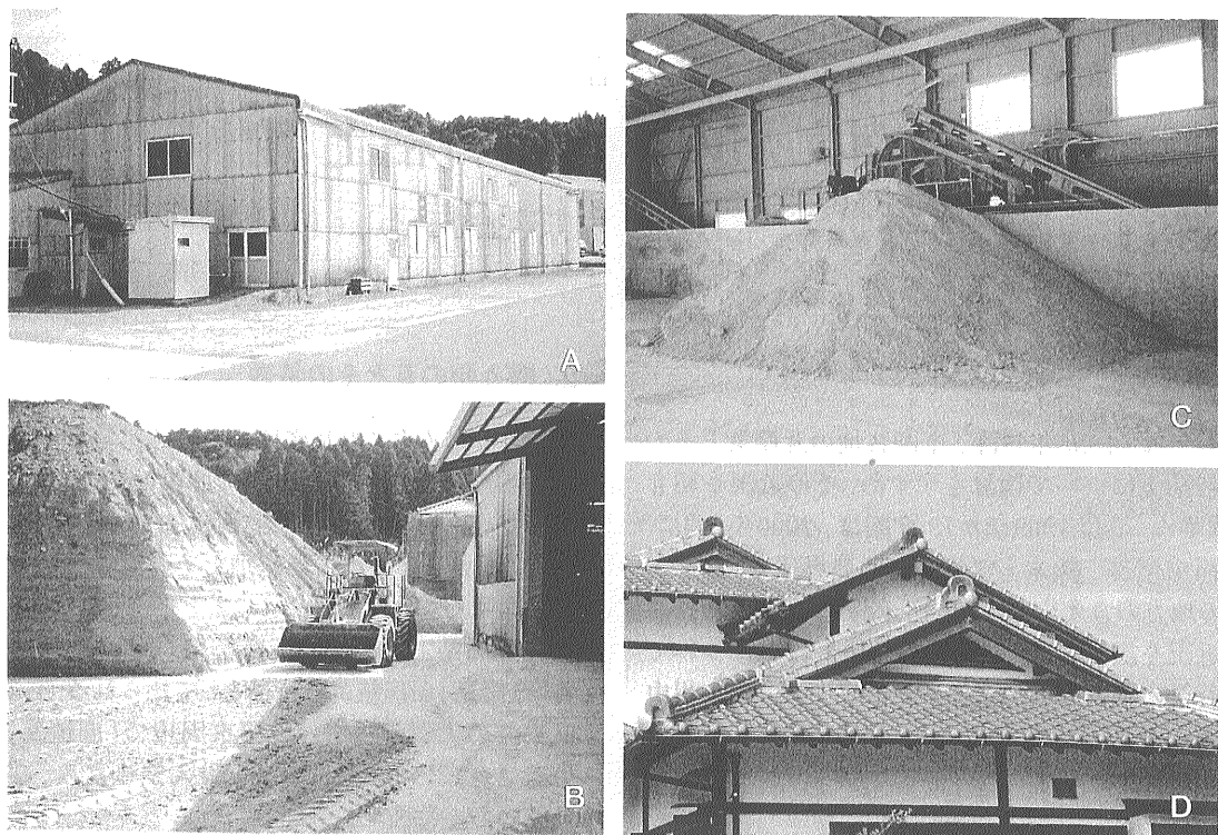
写真2 日置瓦工業協同組合の原料粘土処理工場。A.工場は町の北側の山裾にある。B.工場の脇に山積まれた粘土の山がくずされ調整プラントへ入れられる。C.工場内には調整された粘土が出荷を待っている。D.工場の脇に造られた住宅団地。屋根はもちろん重厚な日置瓦である。
