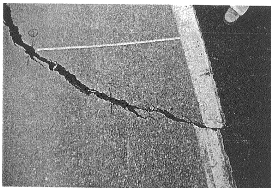
写真2 有珠火山北麓の壮瞥温泉地区にある壮瞥研修センター北の道路上(第1図C地点)でみられた右横ずれ雁行割れ目群の一つ。3月31日11:05撮影。7cm以下の水平変位がみられた。
