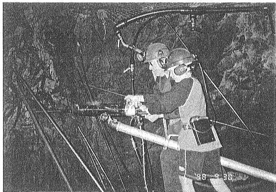
写真6 地下61メートルの坑内で削岩機を使っているところ(セントラル・デボラ・ゴールド・マイン)。
