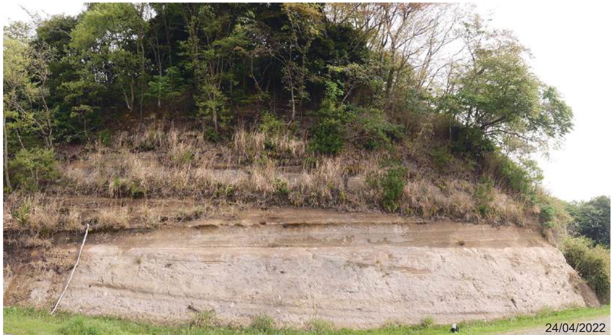
付図1 A地点の露頭写真。Aa～Ad：付図2の地質柱状図作成地点。ta, tb, t5-t12：凝灰岩層。α, β：砂岩層あるいは凝灰岩層。
