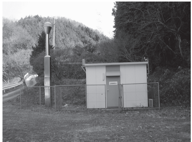
第2図: 安富GPS局の外観
