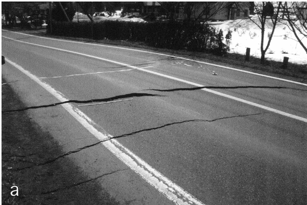
第3図 a: 地点Aの右横ずれ雁行状割れ目群(道路の北西側からみた状況;3月31日10時頃). b: 地点Cの右横ずれ割れ目(道路の北西側からみた状況;4月1日11時頃).
