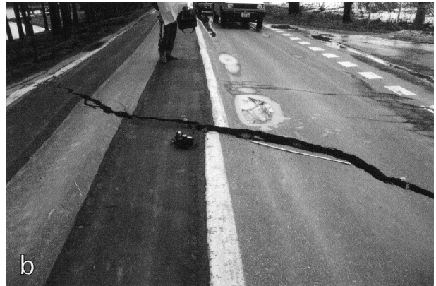
第3図 a: 地点Aの右横ずれ雁行状割れ目群(道路の北西側からみた状況;3月31日10時頃). b: 地点Cの右横ずれ割れ目(道路の北西側からみた状況;4月1日11時頃).
