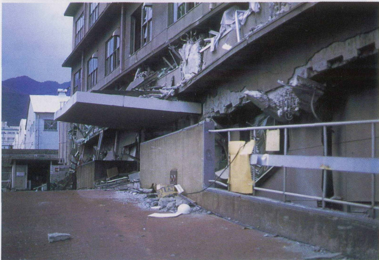
第5図 神戸市中央区における鉄筋コンクリート造の建物の被害。4階建ての建物の1階及び2階部分が潰れている。写真手前側に鉄筋が折れ曲った状態が示されている。
