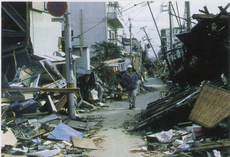
第3図 神戸市灘区における家屋被害の集中した地区の1995年2月初旬の状況。木造家屋の多くが倒壊し、道路をふさぐ状態になっている。
