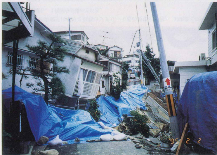
第10図 西宮市五月ヶ丘における急斜面の崩壊。数軒の民家が巻き込まれている。浅いスランプによる段丘崖の後退現象であり、一般に小規模であるが、移動速度が速く危険性が高い斜面変動である。
