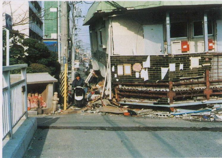
第6図 神戸市東灘区における鉄骨造の建物の被害。道路をふさぐように倒れ、1階部分が潰れた状態になっている。
