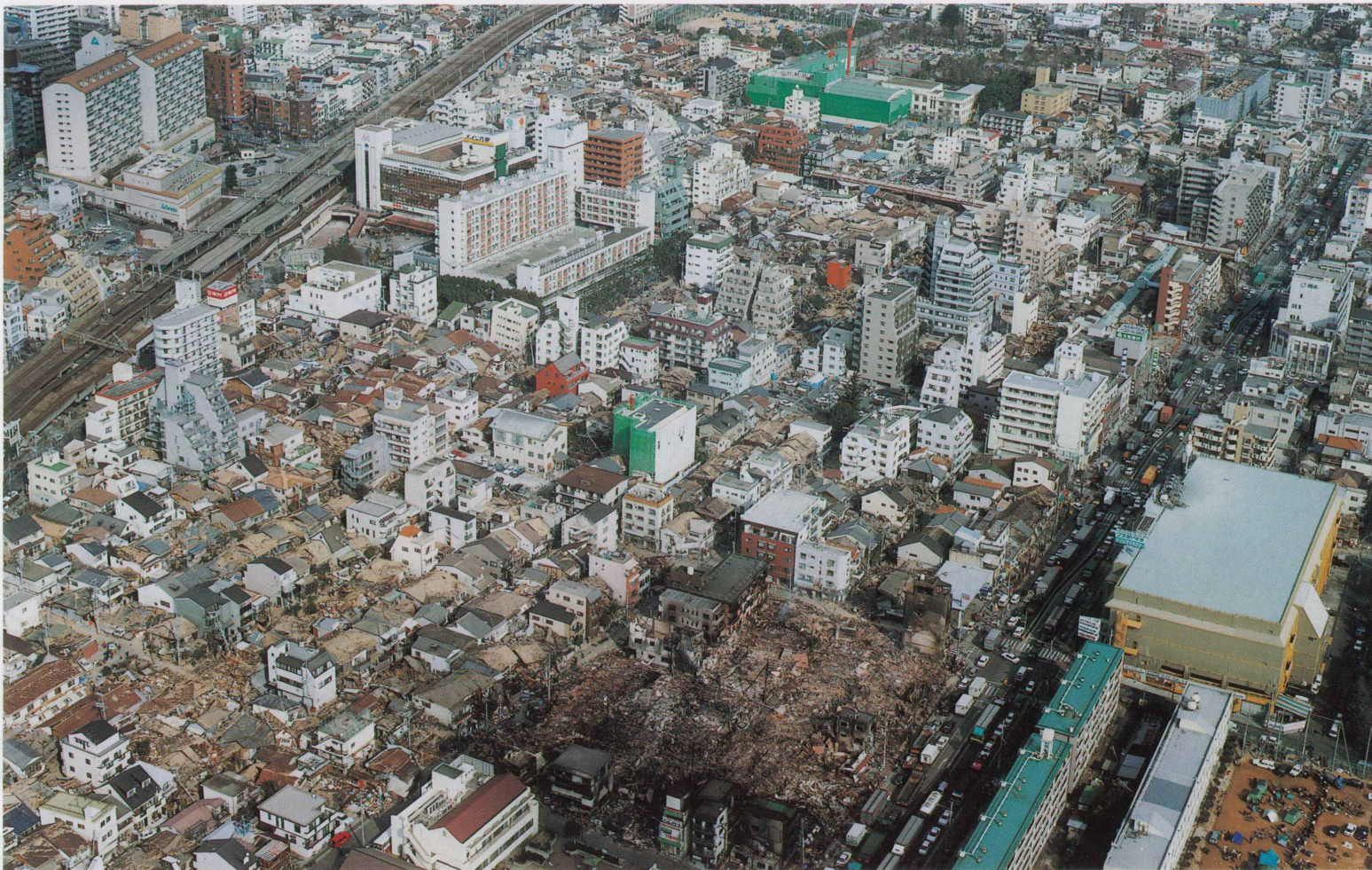
第1図 地震発生日の1月18日午前10時頃に撮影の空中写真。南西から北東方向に向かって撮影。左手奥の駅がJR六甲道駅。この駅の手前側では鉄道高架が落下している。また写真中央手前では火災によって建物が焼失している。鉄道とこの焼失区画の間で、多くの家屋が倒壊している。現地調査結果によると、この範囲の木造家屋の大部分が全壊の被害である。[撮影：中日本航空(株)]
