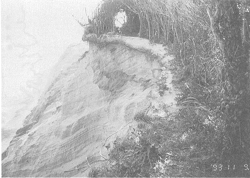
第 11 図 火砕丘の火口縁に達した海食崖 (N測線付近) 海側へ傾斜した火砕丘堆積物と崩落直前の遊歩道。
