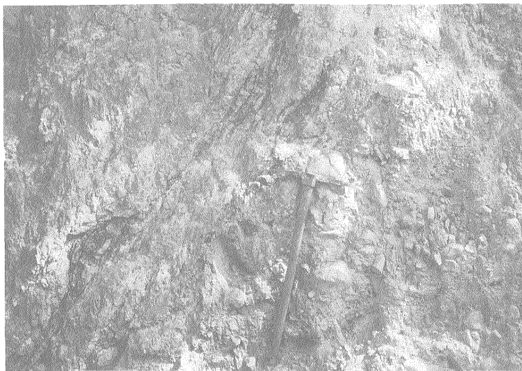
第7図 断層露頭 美馬町中上北東(Loc. 2) 和泉層群(左)が土柱層の礫層上に衝上している
