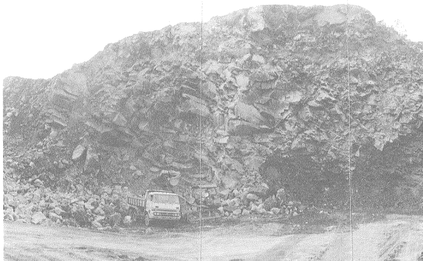
第8図 泥流丘(石倉山)にある多田組十面沢採石場 (位置は第10図に示してある)
