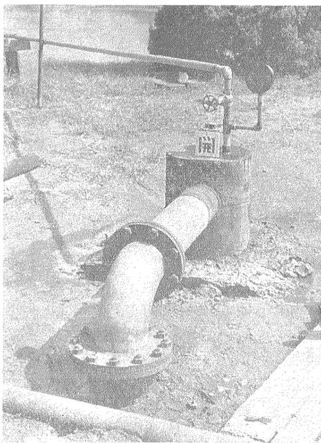
図版3 東邦レーヨンK.K.工場構内圧入井(1号井)。太い円筒状のもの、細い管は排圧管。
