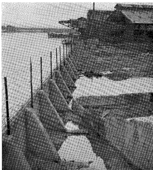
図版 2 尼崎市における地盤沈下，塚の内外，常に同一水面を保つている沈下地帯の一角
