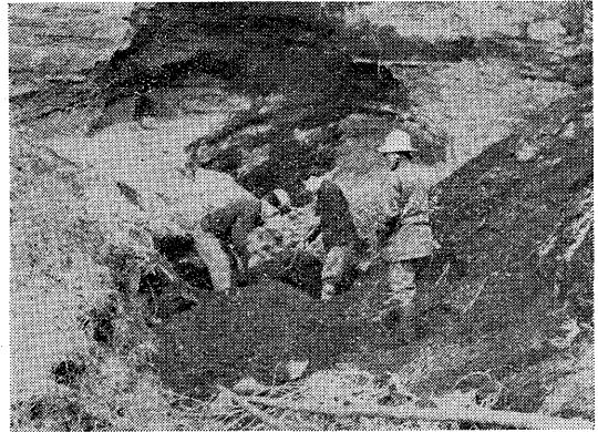
図版 4 No.1におけるパイプ挿入準備
