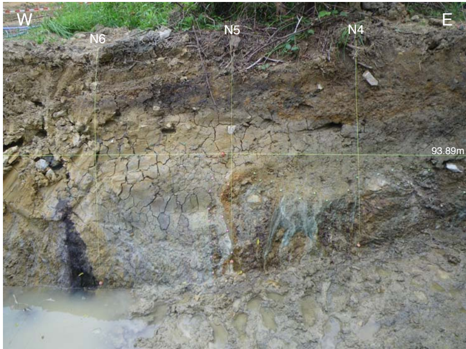
第 17 図. 後山 C トレンチ北壁面断層部分の写真. ピンクのパインは断層, その他のピンは地層境界を示す. グリッドは垂直面上での 1 m 間隔.
