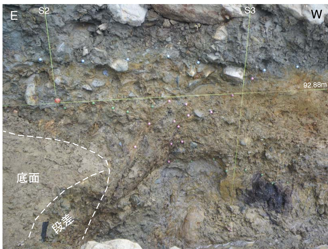
第15図. 後山Bトレンチ南壁面断層部分の写真. ピンクのパインは断層, その他のピンは地層境界を示す. グリッドは垂直面上での1m間隔.
