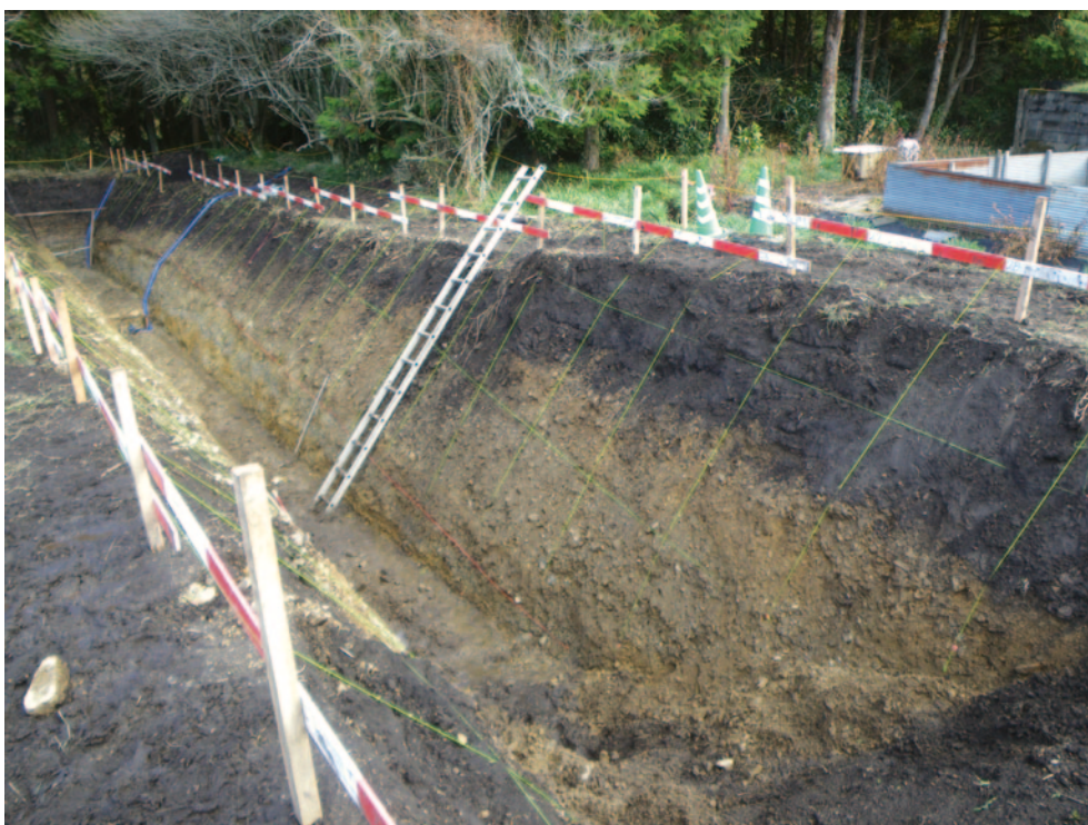
第6図. 佐野トレンチ壁面の写真. 上：北西壁面，下：南東壁面.
