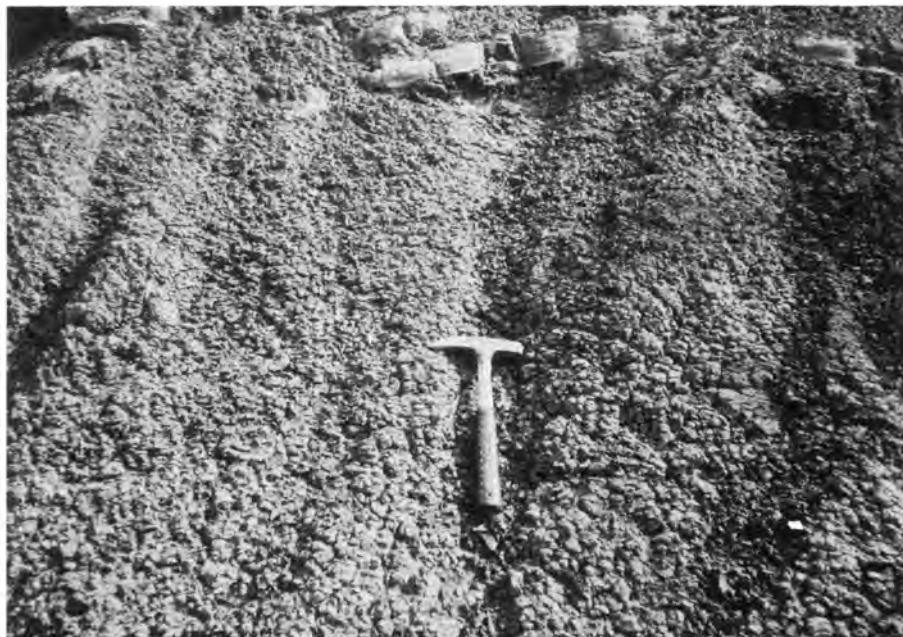
第70図 綾層泥岩の風化状態（高岡町内山地区）。
