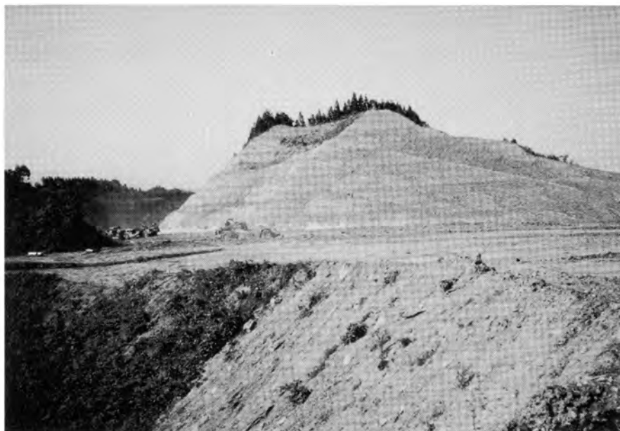
第73図 大規模住宅団地の造成工事現場(宮崎市) 後方は宮崎層群の砂泥互層。
