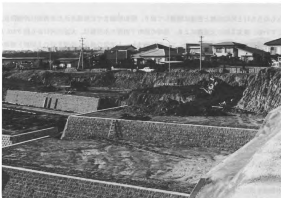
第72図 宅地造成地の状況 (宮崎市)
