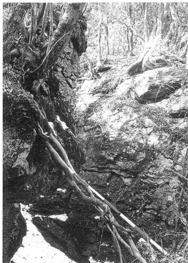
第17.2図 代次地すべりにおける尾根の開口クラック (吾川郡いの町上八川下分代次)
