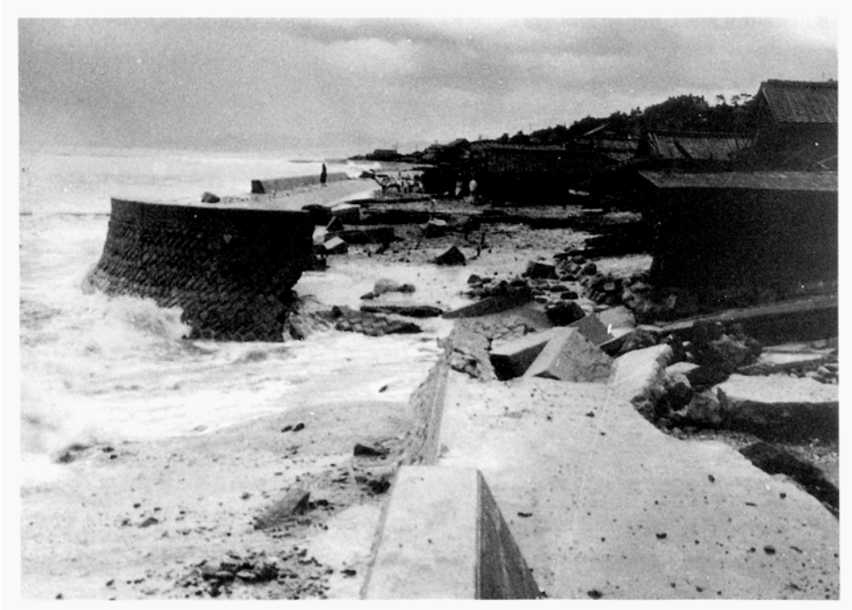
第47図 昭和36年「第二室戸台風」による海岸の被害（東浦町下田付近）[東浦町役場提供]
