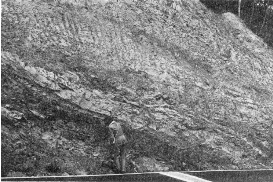
第26図 相生層群鶴亀上部累層加賀美部層の模式地における泥岩火山砂礫岩互層
